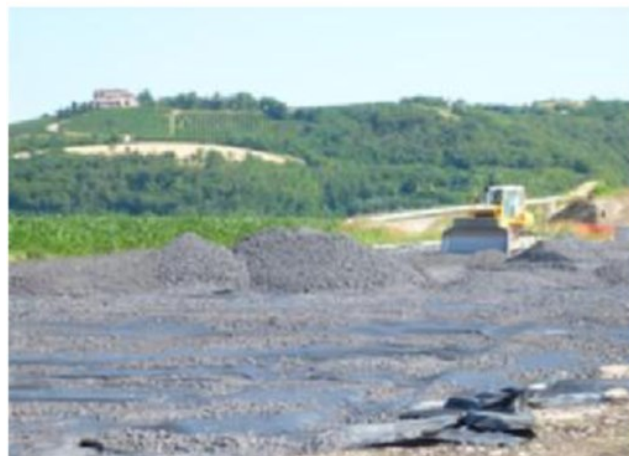
Il sottofondo del manto autostradale nella zona di Montegalda
