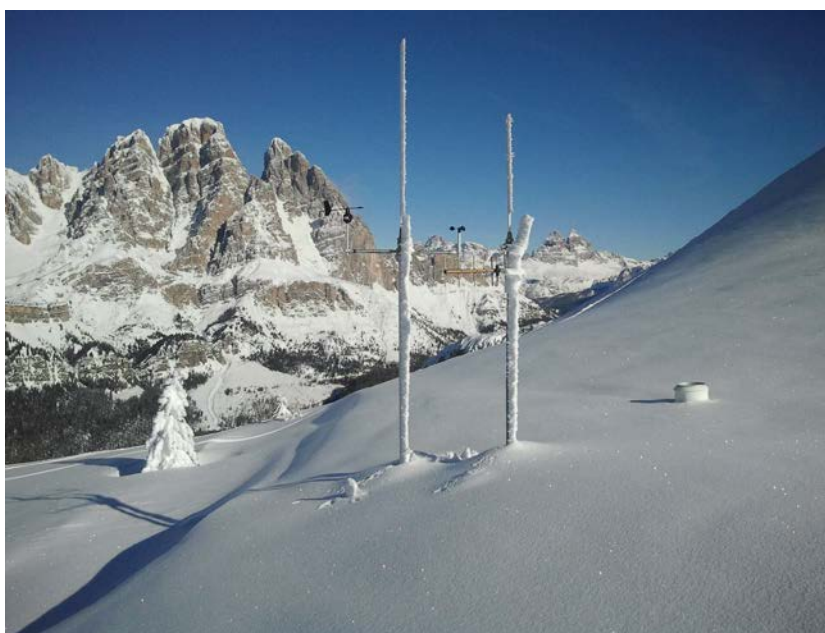
Fig. 32 - Stazione meteorologica del Faloria (2240 m s.l.m.) il 22 gennaio 2014: A destra è visibile la bocca del pluviometro a 2 metri dal suolo, al centro i sensori del vento che sono posti a 5 metri dal suolo
