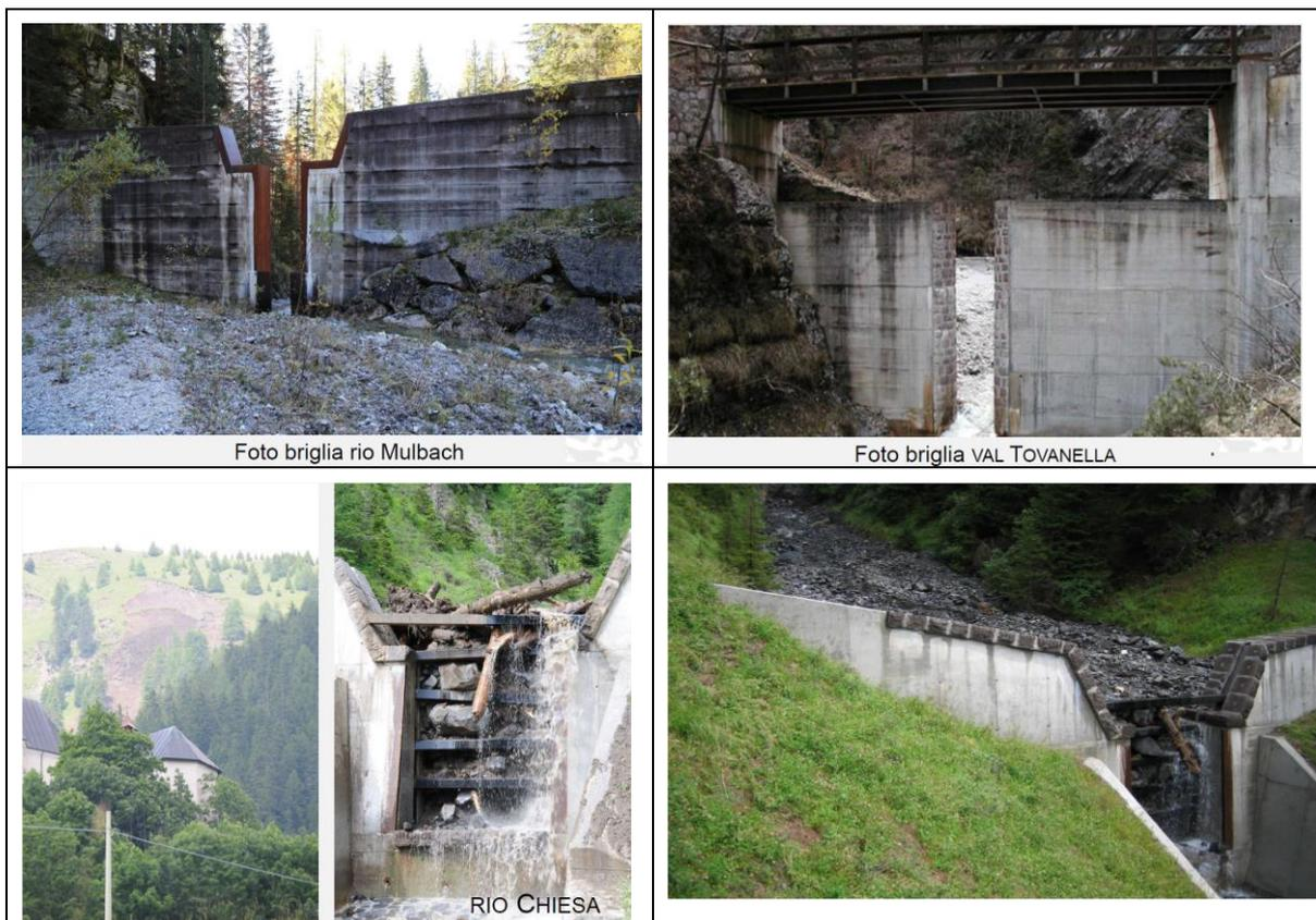
**5 - BRIGLIE FILTRANTI (FONTE: REGIONE DEL VENETO).** La serie di immagini illustra diverse briglie filtranti nel Veneto, strutture idrauliche progettate per contenere e rallentare il flusso di detriti e sedimenti in aree montane, proteggendo così le zone a valle. Queste briglie, realizzate in cemento armato, sono dotate di grandi aperture che permettono all'acqua di passare, trattenendo al contempo detriti di maggiori dimensioni.
