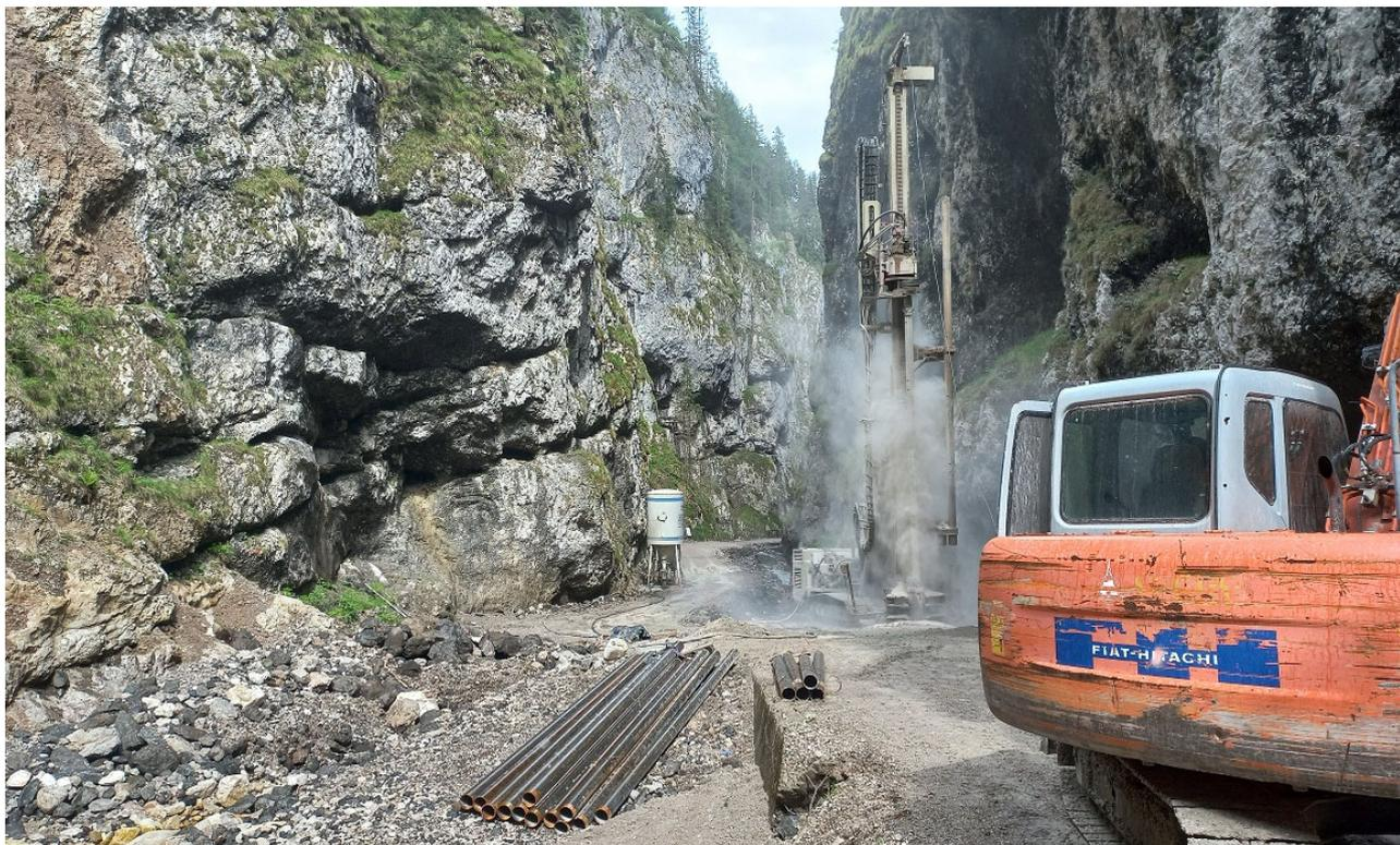
Figura 7 - Realizzazione di fondazioni profonde (micropali)
