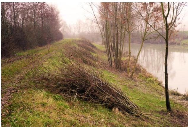
**Fig. 29.** Taglio e raccolta delle ramaglie lungo i fiumi e canali prossimi alla laguna per l'allestimento delle fascine
